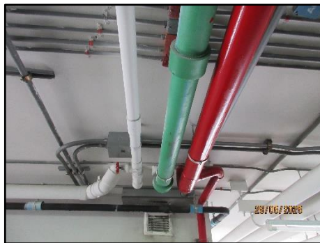
รูปที่ 2-42 ระบบท่อน้ำดับเพลิงหรือท่อเย็น (Standpipe System)
