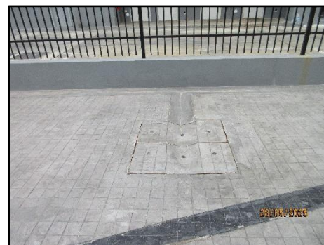
รูปที่ 2-17 ป่อพักน้ำภายในโครงการ
