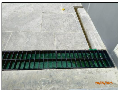
รูปที่ 2-18 ตะแกรงดัักขยะก่อนระบายน้ำออกจากโครงการ
