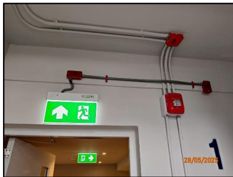
รูปที่ 2-39 อุปกรณ์ส่งเสียงสัญญาณแจ้งเหตุ (Fire Alarm Indicating Device)
