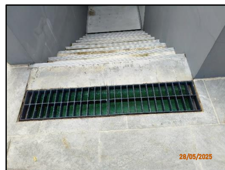
รูปที่ 2-18 ตะแกรงดัักขยะก่อนระบายน้ำออกจากโครงการ
