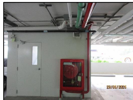
รูปที่ 2-43 ตู้เก็บสายฉีดน้ำดับเพลิง (Fire Hose Cabinet)
