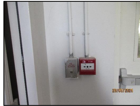
รูปที่ 2-38 ปุ่มกดแจ้งสัญญาณอัคคีภัย (Fire Alarm Manual Station)
