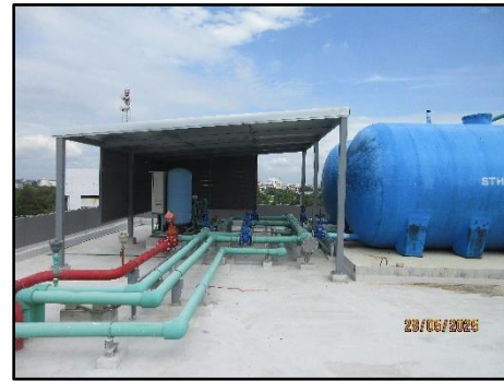
รูปที่ 2-41 ระบบสำรองดับเพลิง (Fire Water Reserve) ระบบจ่ายน้ำดับเพลิงของแต่ละอาคาร
