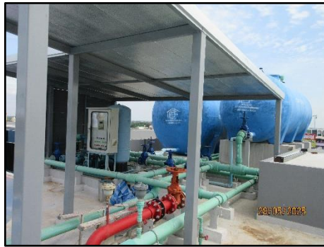
รูปที่ 2-41 ระบบสำรองดับเพลิง (Fire Water Reserve) ระบบจ่ายน้ำดับเพลิงของแต่ละอาคาร
