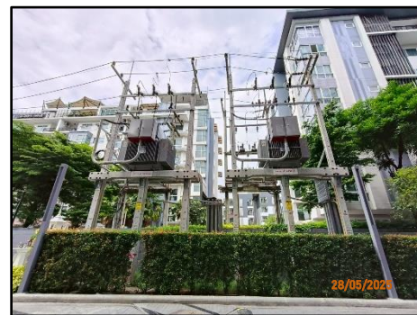
รูปที่ 2-31 หม้อแปลงไฟฟ้าของโครงการ
