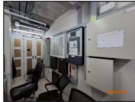
รูปที่ 2-35 แผงควบคุมระบบแจ้งเหตุอัคคีภัย (Fire Alarm Control Panel: FCP)
