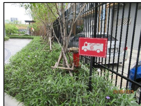
รูปที่ 2-40 หัวรับน้ำดับเพลิง (Fire Department Connection)
