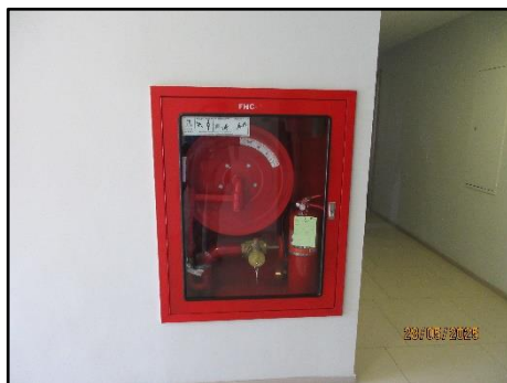
รูปที่ 2-43 ตู้เก็บสายฉีดน้ำดับเพลิง (Fire Hose Cabinet)
