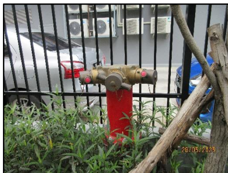
รูปที่ 2-40 หัวรับน้ำดับเพลิง (Fire Department Connection)
