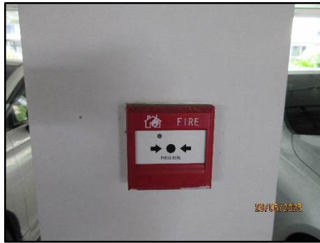
รูปที่ 2-38 ปุ่มกดแจ้งสัญญาณอัคคีภัย (Fire Alarm Manual Station)
