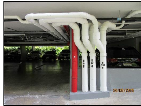
รูปที่ 2-16 ท่อระบายน้ำภายในโครงการ
