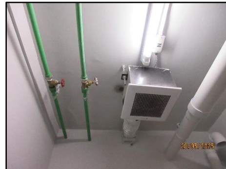
รูปที่ 2-29 ระบบระบายอากาศภายในห้องพักมูลฝอย
