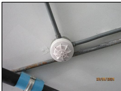
รูปที่ 2-37 เครื่องตรวจจับความร้อน (Heat Detector: H)
