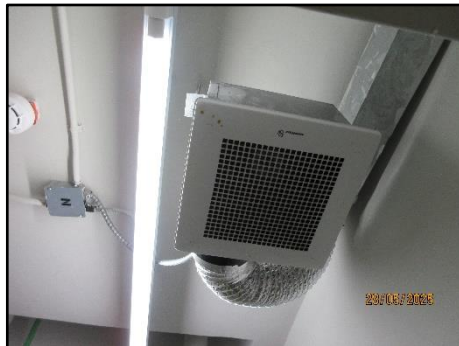
รูปที่ 2-29 ระบบระบายอากาศภายในห้องพักมูลฝอย
