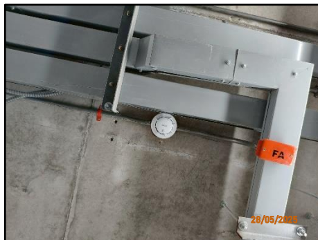
รูปที่ 2-36 เครื่องตรวจจับควัน (Smoke Detector: SD)
