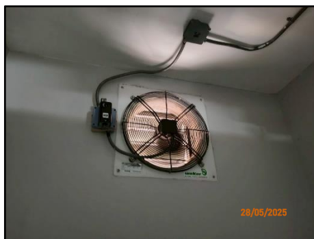
รูปที่ 2-46 การติดตั้งพัดลมระบายอากาศและช่องเปิดระบายอากาศบนตัวอาคาร
