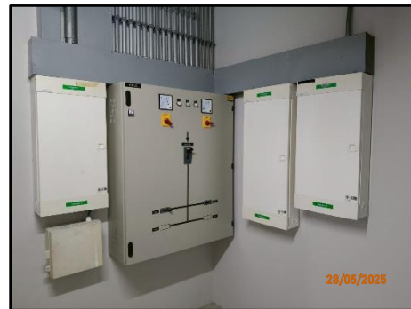
รูปที่ 2-33 ระบบไฟฟ้าหลัก (ห้อง MDB) ในโครงการ
